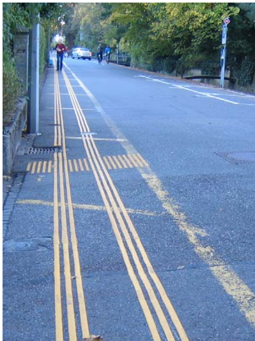
Figure 18 Voie longitudinale pour piétons marquée avec des lignes de guidage tactilo-visuelles
