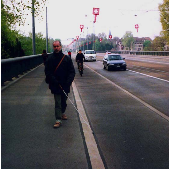
Figure 20 Pont Wettstein, Bâle: Séparation de la piste cyclable et de la voie piétonne avec différence de niveau et bordure oblique
