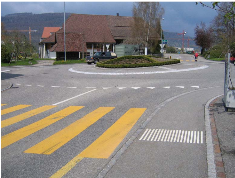
Figure 30 Passage pour piétons à un giratoire: Marquage avec une zone d'attention tactilo-visuelle
