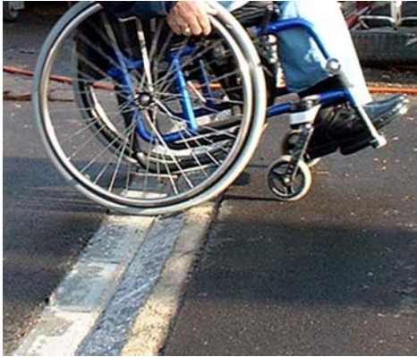
Figure 12 Des bordures étroites inclinées de 4 cm de hauteur maximum sont franchissables avec un fauteuil roulant.
