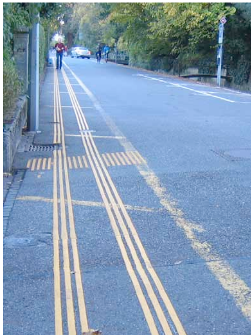
Abbildung 18 Längsstreifen für Fussgänger mit taktil-visueller Leitlinie markiert
