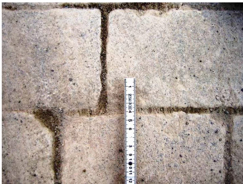
Abbildung 43 Gestockte Pflästerung mit minimaler Fugenbreite
