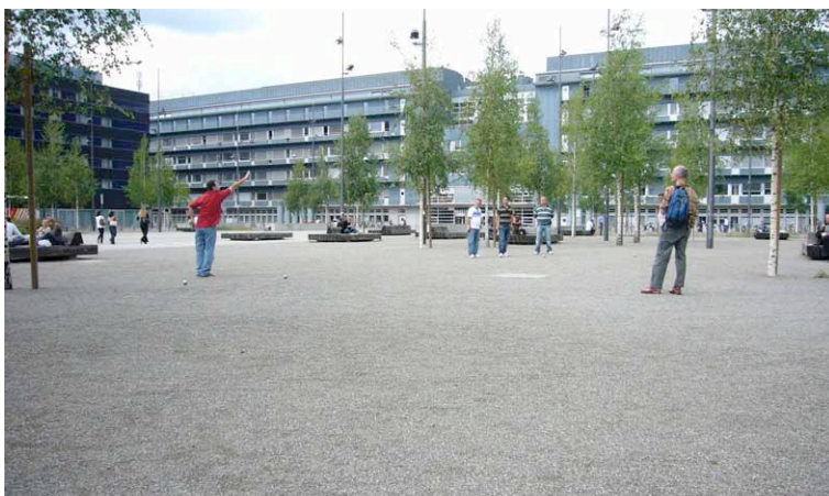
Abbildung 42 Tourbinenplatz, Zürich: Mit Stabilizer verdichteter Kiesbelag
