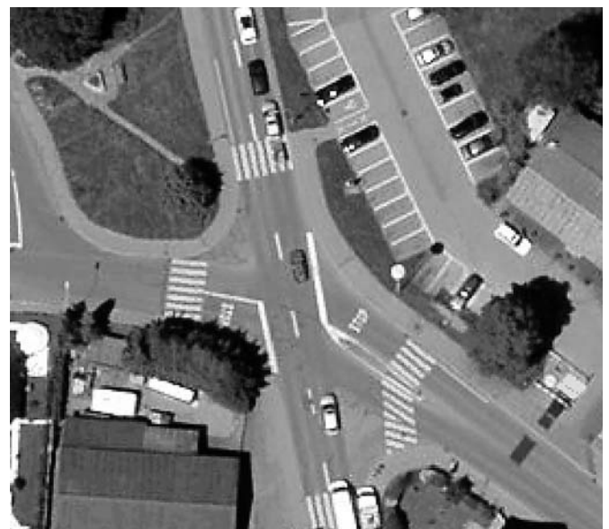
Exemple d'un cas problématique avec passages pour piétons en biais à Uster, canton de Zurich Source: GIS canton de Zurich
