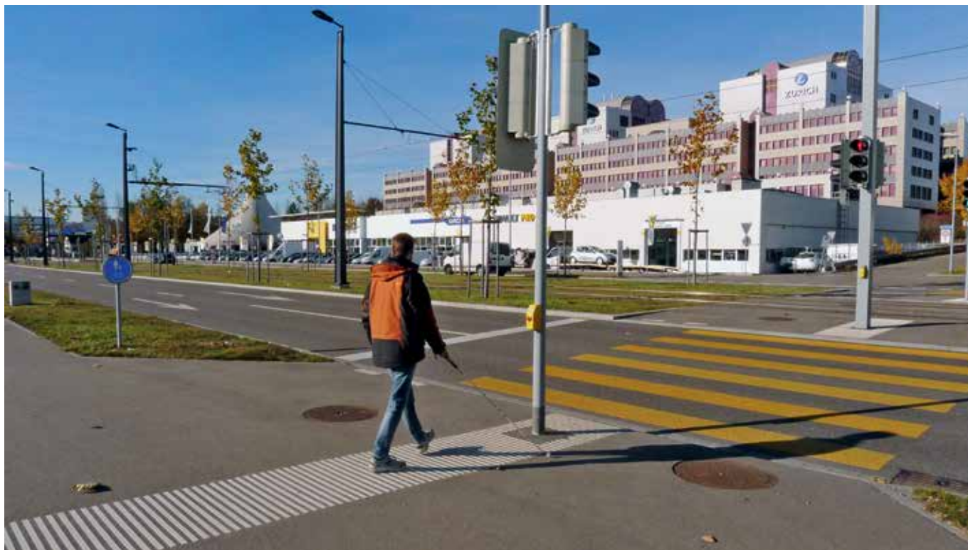
7 | Dank der taktil-visuellen Markierung findet auch eine blinde Person den Masten mit dem Anforderungsgerät und kann dort am taktilen Signal die Grünphase ertasten (Foto: Schweizerische Fachstelle).
