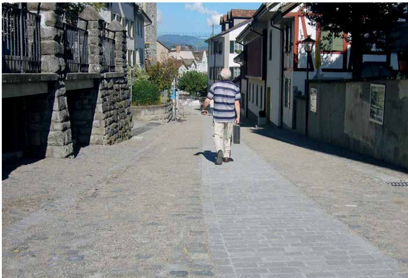
4 | Der für Gehbehinderte mit gestockten Pflastersteinen ausgeführte Hauptweg erhöht den Komfort für alle (Foto: Schweizerische Fachstelle). 4 | La voie principale réalisée avec des pavés bouchardés pour les handicapés moteur accroît le confort pour tous (photo: Centre suisse).
