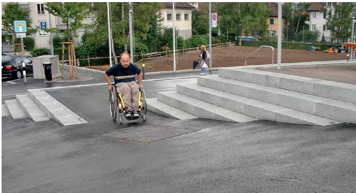
1 | Eine zu steile Rampe bringt viele Rollstuhlfahrer an die Grenze ihrer Möglichkeiten, aber sie wirkt sich nicht als absolutes Hindernis aus und kann zur Not mit Unterstützung oder motorisierten Fahrhilfen bewältigt werden (Foto: Schweizerische Fachstelle).
