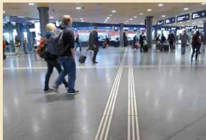
Des lignes de guidage tactilo-visuelles conduisent les voyageurs en situation de handicap depuis les quais de la gare sous l'aéroport de Kloten jusqu'aux guichets des CFF ou ceux pour l'enregistrement des bagages.
