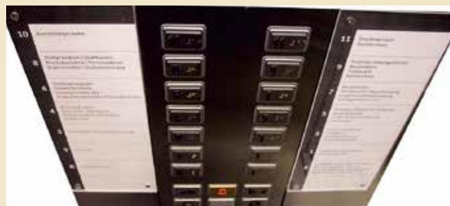
Le panneau de commandes a une luminance L de 2 cd/m 2 . Dans ces conditions, l'œil ne perçoit que difficilement les contrastes de luminosité C_m .
