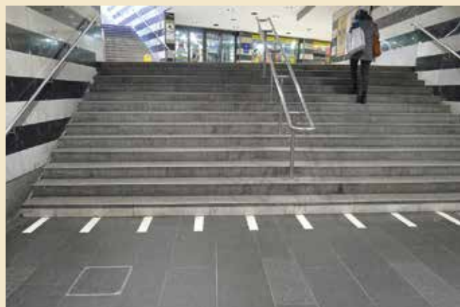
En s'approchant de l'escalier depuis le bas, les bandes perpendiculaires et la contremarche blanche de la première marche remplissent sans équivoque leur rôle de repère.
