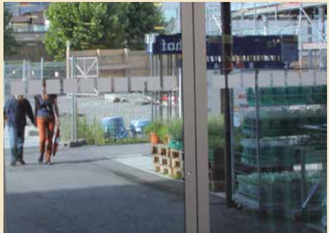
Ce marquage translucide offre un contraste trop faible par rapport à l'environnement. Des reflets en perturbent de plus la perception.
