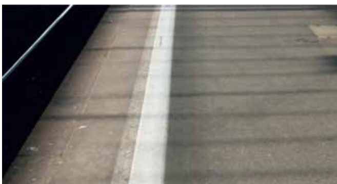
Une ligne de sécurité blanche d'une largeur entre 15 et 20 cm remplit sa fonction d'avertissement même sous une faible clarté.
