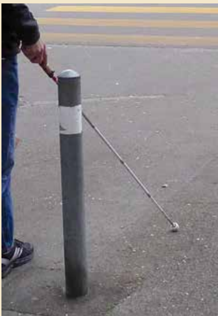
La présence du poteau dans cette zone piétonne est soulignée par un marquage contrasté.
