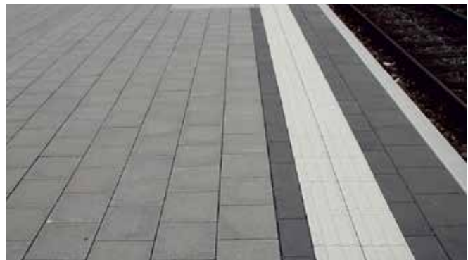
La structure clairement géométrique des lignes de sécurité tactilo-visuelles exécutées en pavés de béton est primordiale. Le contraste de luminosité est obtenu grâce aux bandes contrastantes sombres qui les bordent.
