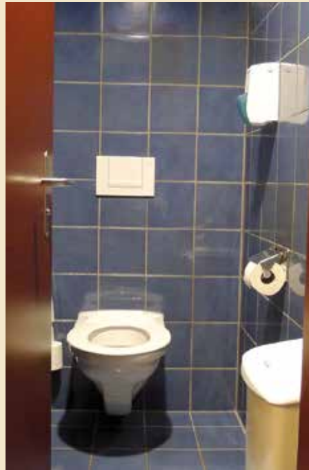
Le contraste de luminosité entre les appareils sanitaires, les dispositifs de commande et les faïences facilite la localisation des divers éléments.
