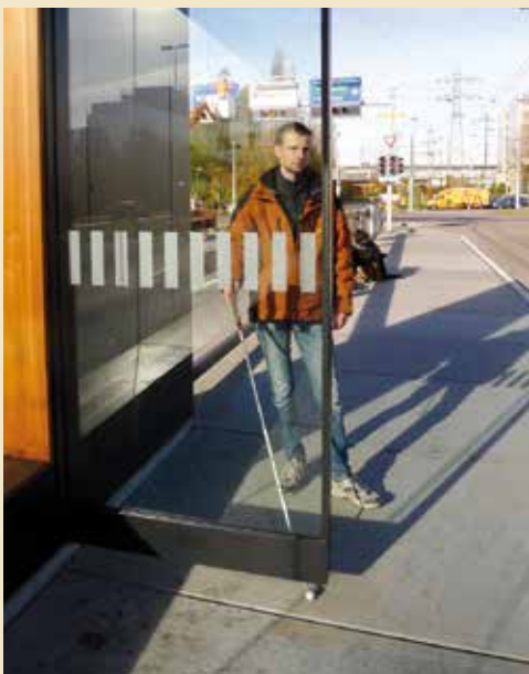
Des éléments vitrés faisant saillie sur la surface piéton, par exemple à des arrêts de tram ou de bus, doivent être marqués, pour ne pas mettre en danger des personnes malvoyantes.
