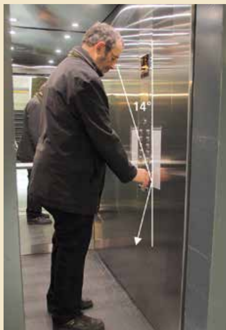
Tombant sur le panneau de commandes avec un angle d'incidence de 14°, la lumière est réfléchiée vers le bas et non vers l'observateur. Le panneau en acier chromé est alors perçu comme une surface sombre.
