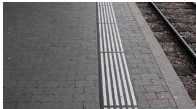
Les lignes de sécurité tactilo-visuelles exécutées en matière plastique à deux composants offrent un bon contraste de luminosité. Leur effet est renforcé par le changement de matériaux, leur motif géométrique et à leur tridimensionnalité.
