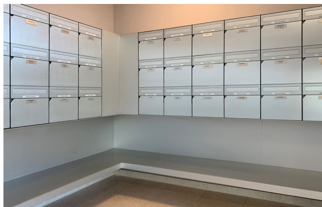
Briefkastenanlage mit Abstellfläche: unterste Reihe der Ablagefächer ist vom Rollstuhl aus gut erreichbar
