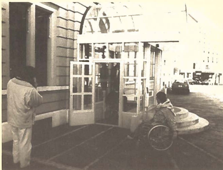
Neues Eingangsportal mit Hebebühne für ein älteres, kantonales Verwaltungsgebäude in La Chaux-de-Fonds. 1989 erhielt dieser Umbau die Auszeichnung behindertengerechter Bauten. Architekt: Jimmy Liengme, La Chaux-de-Fonds. Foto: Fachstelle
