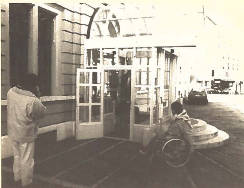
Nouvelle porte d'entrée avec plate-forme élévatrice dans un bâtiment administratif cantonal à La Chaux-de-Fonds. En 1989, grâce à cette transformation, une distinction fut accordée au bâtiment, considéré comme "adapté aux handicapés". Architecte: Jimmy Liengme, La Chaux-de-Fonds Photo: Centre suisse
