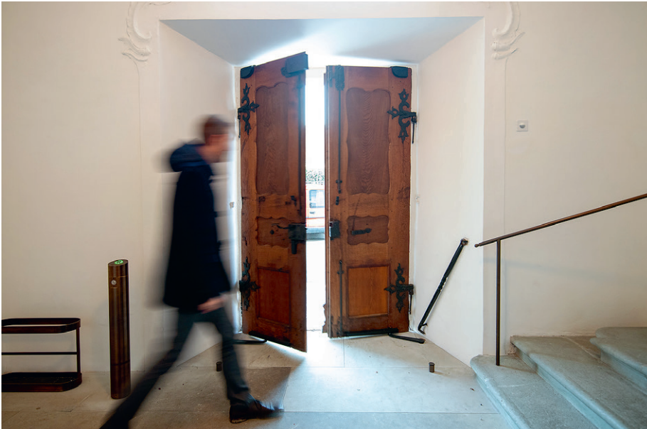
Seiteneingang Dom, Arlesheim: Von aussen öffnet sich die Türe automatisch über einen Infrarotsensor. Innen wird die Türe über einen hindernisfreien Sensortaster in der Bediensäule links neben der Türe geöffnet.
