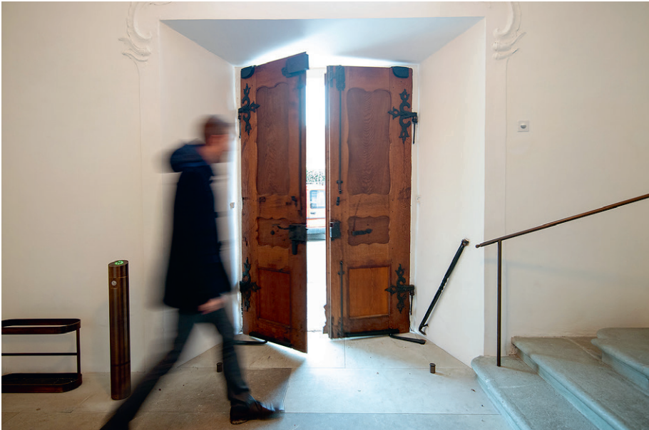
Entrée latérale, Dom d'Arlesheim : de l'extérieur, la porte s'ouvre automatiquement grâce à un capteur infrarouge. De l'intérieur, la porte s'ouvre à l'aide d'un bouton-poussoir placé dans la colonne de commande à gauche de la porte.
