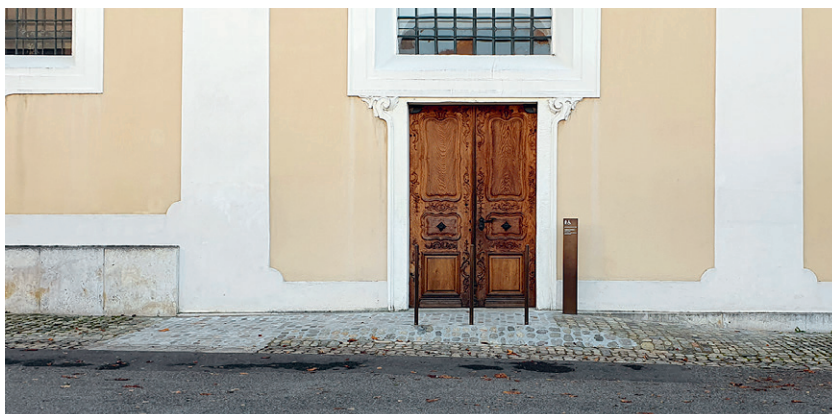
Entrée latérale Dom, Arlesheim: le traitement mécanique des pavés permet de créer un contraste avec le reste du pavage et de guider ainsi le visiteur. Le bord du palier est entièrement plan.
